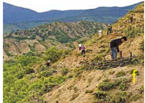
Şekil 4. a. Taşıntı barajı (DSİ Arşivi), b. kuru duvar eşik (HE Çelik), c. kütüklerle kafes taşıntı barajı, Avusturya (HE Çelik), d. Van Özalp'ta hurda araç lastiğiyle oyuntu kontrolü (O Yavuzçoban-OGM), e. teras (OGM Arşivi), f. örme çit (OGM Arşivi)
