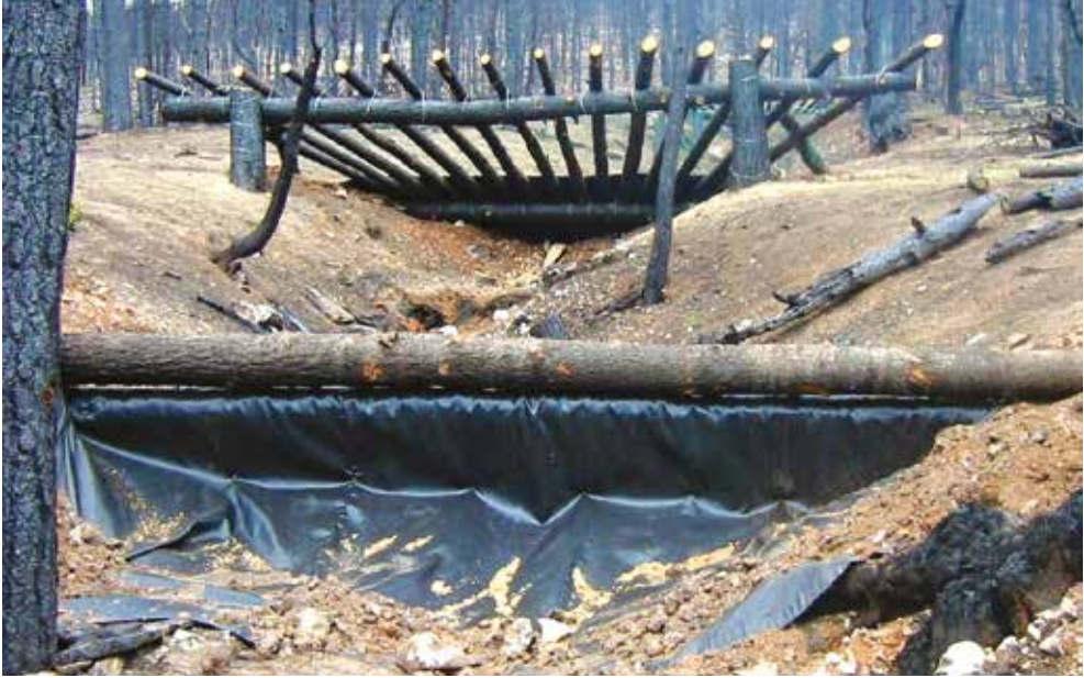
Şekil 2. Menfez tıkanmasına karşı menfezin yukarısında yanmış ağaçlarla ve yüksek kesilen dip kütükleriyle inşa edilen süzücü bir yapı (URL 1)
