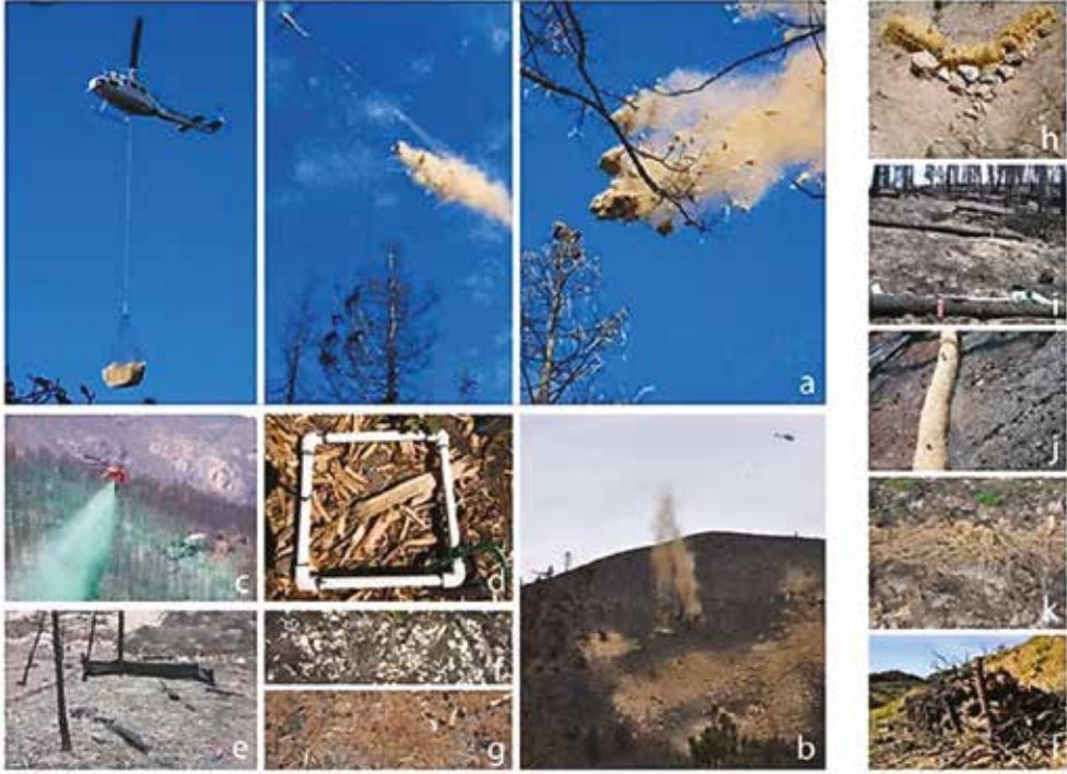
Şekil 3. Bazı malç malzemesi, yüzeysel akış kontrol yapıları ve uygulandıkları yerler: a) helikopterle saman balyası nakliyesi (2005 School Yangını, Washington, ABD); b) helikopterle malç uygulaması (2015, Lugo, İspanya); c) havadan sulu malçlama (2002, Colorado, ABD); d) odun yongaları/kuru malç (2012, Colorado, ABD); e) kuru malçlama araştırma alanı (2002, Colorado, ABD); f) odun yongası malçı (2006, Pontevedra, İspanya); g) ağaç kabuğu malçı (2010, Pontevedra, İspanya); h) bir oyuntuda saman balyası eşik (2010, Utah, ABD); i) kütük tuzak (2002, California, ABD); j) saman sucuk teras (2000, Montana, ABD); k) dallarla malçlama (2006, Pontevedra, İspanya); l) kütük eşik (2015, Or'es, İspanya) (Girona-García, 2021).
