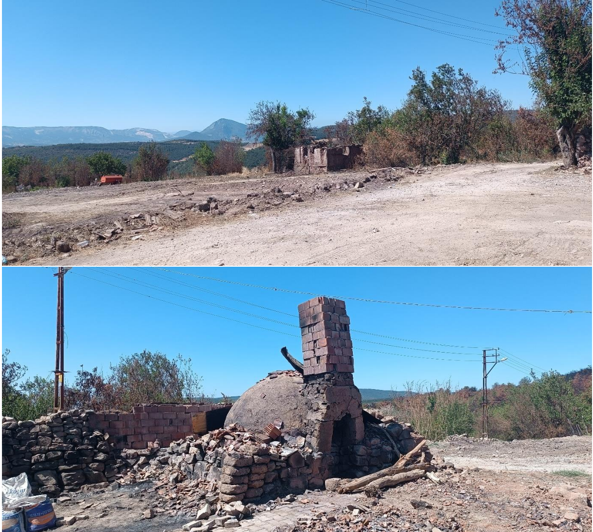
Şekil 1. Yerleşim yerlerindeki yangın zararlarına ilişkin görüntüler.
