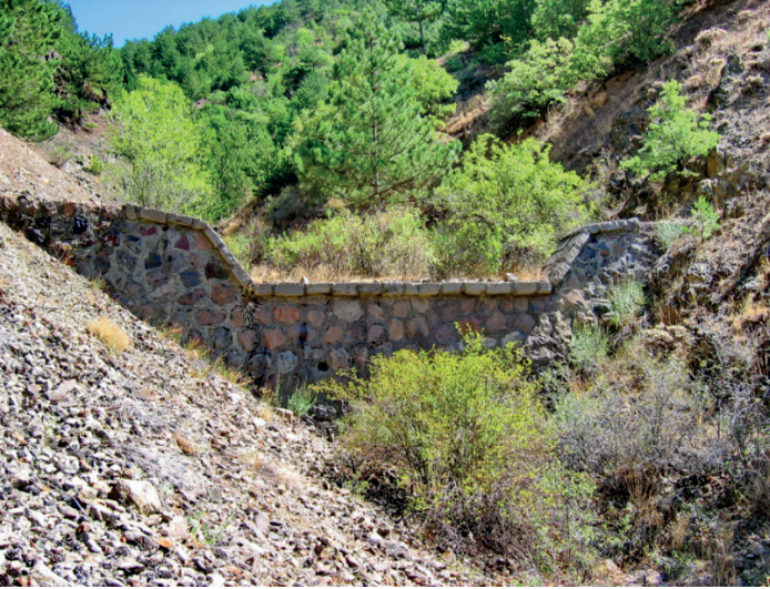
Şekil 8. OGM'nin Ankara - Kızılcahamam'da 1960'larda yaptığı bir taşıntı barajının 2007 yılındaki görünümü (Çelik, 2025)
