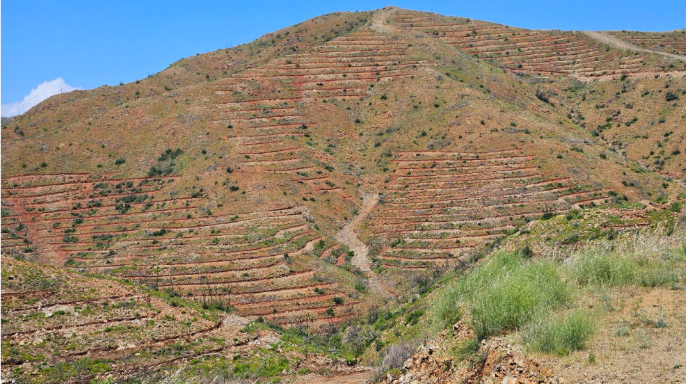
Şekil 2. Marmaris Milli Parkı'nda yangın sonrası yapılan teraslama uygulamalarına örnek (Fotograf : Gelincik Deniz Bilgin)
