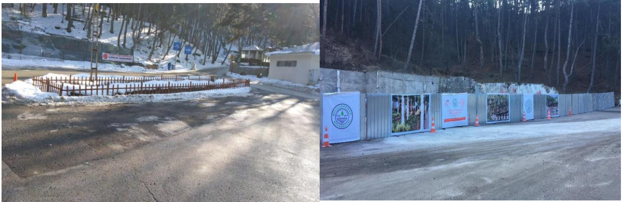
Foto-5,6: DSİ’ye Ait Dere Yatağındaki Kanal, 2006/27 Sayılı Başbakanlık Genelgesine Aykırı Olarak Kızılcahamam Belediyesince Kapatılmıştır.
