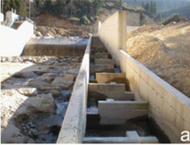
Şekil 10. (a) Su Olmayan Balık Geçitleri ve (b) Balık Ölümleri
