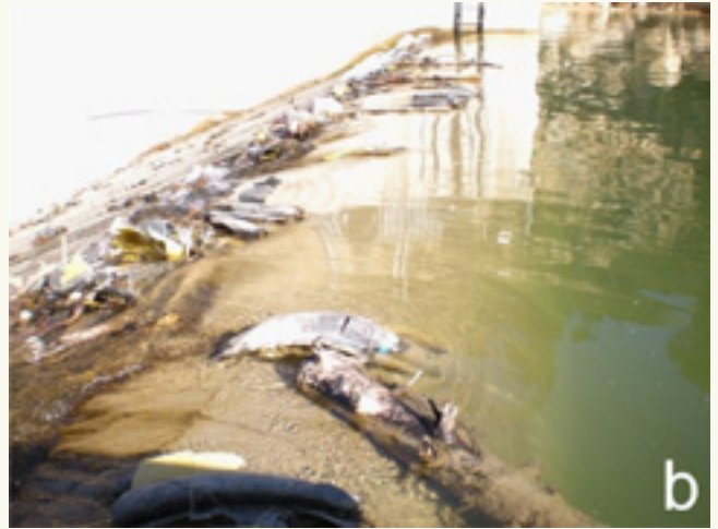
Şekil 9. HES Projelerinden Etkilenen Endemik Alabalık Türü (a) Salmo trutta labrax ve (b) Yanlış İnşa Edilen Bir Balık Geçidi Girişi
