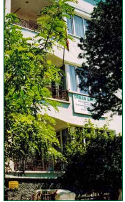
Yıkılan yurt binası, Seyrantepe 2016
