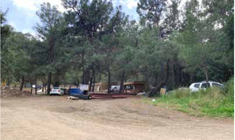
Alacasu Koyundaki inşaat alanından görünüm
