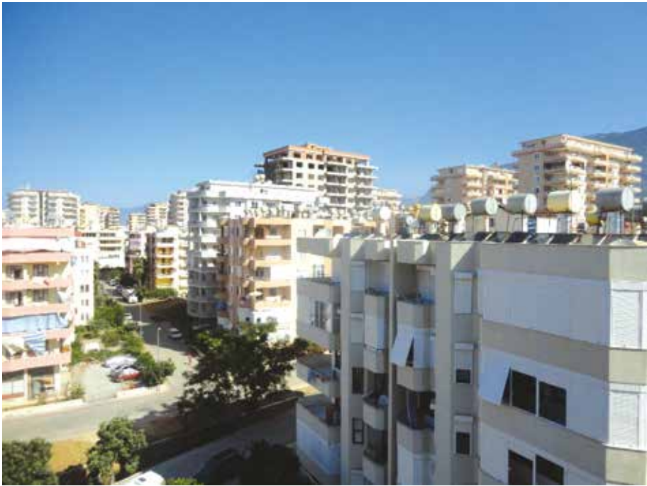
Şekil 6. Beş katlı yapı teraslarında güneş panelleri, arkada yeni bloklar
